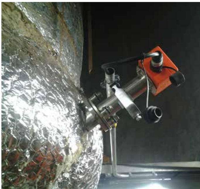
**FIGURA 1** - Il misuratore di portata volumetrica FLOWSIC100 misura la velocità di flusso dei Gas
